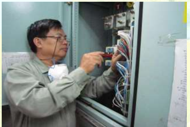
Thầy Trần Việt Tiến đấu nối dây Bảng điện chính trên tàu thủy
